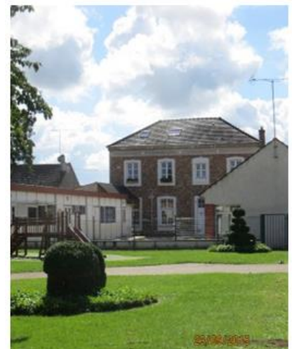
Vue arrière de la mairie
