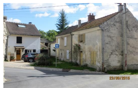
Mur sur une cour commune
