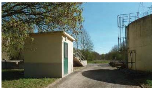
Equipements de la station d'épuration
