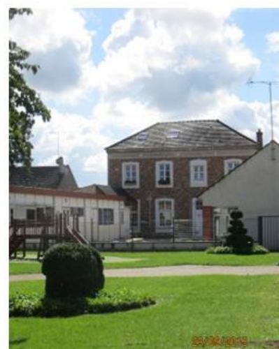
Vue arrière de la mairie
