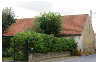
Pignon et mur Clôture sur rue Décrochement bâti par rapport à la voie
