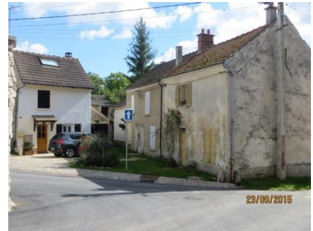
Mur sur une cour commune
