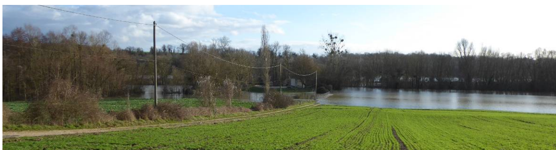
Inondation des terres "les Branlards" en amont de la station d'épuration
